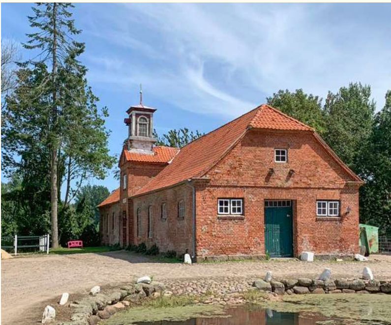
Glockenturm nach der Sanierung, Aufn. 2024 – © Valentin v. Buchwaldt
